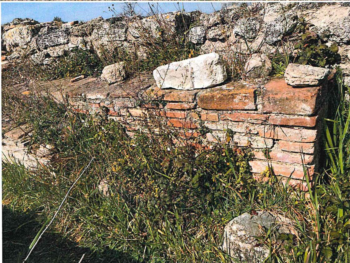
**Descrizione:** si tratta di strutture realizzate con blocchetti di laterizio ottenuti dall'estrazione di materiale locale e dalla sua lavorazione e assemblaggio con l'utilizzo di malta. Il laterizio e la malta risultano particolarmente compatti ma le variazioni termiche e l'azione degli agenti atmosferici producono depositi superficiali, formazione di vegetazione infestante e caduta di blocchetti dalla sommità delle murature.
