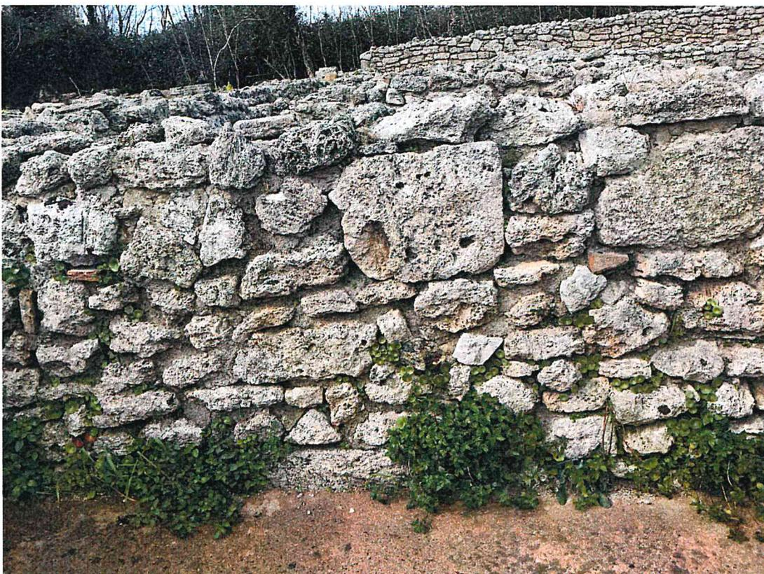
**Descrizione:** si tratta di strutture realizzate con blocchetti di travertino ottenute dall'estrazione di materiale locale e dalla sua lavorazione e assemblaggio con l'utilizzo di malta. Il travertino e la malta risultano particolarmente compatti ma le variazioni termiche e l'azione degli agenti atmosferici producono depositi superficiali e formazione di vegetazione infestante, oltre che la caduta di blocchetti.
