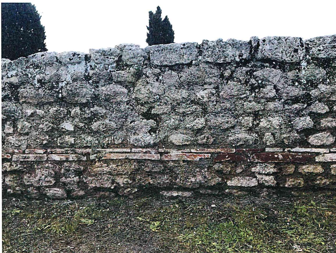
**Descrizione:** si tratta di strutture realizzate con blocchetti di travertino e laterizi ottenute dall'estrazione di materiale locale e dalla sua lavorazione e assemblaggio con l'utilizzo di malta. Il travertino, il laterizio e la malta risultano particolarmente compatti ma le variazioni termiche e l'azione degli agenti atmosferici producono depositi superficiali, caduta di blocchetti dalle creste murarie e formazione di vegetazione infestante.
